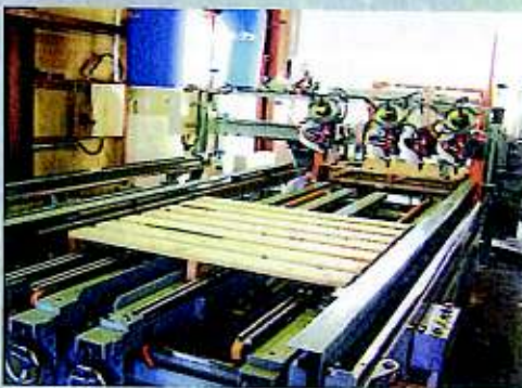
パレット表面打立状況
